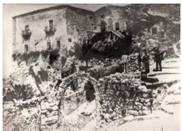
Mura del castello prima del crollo
